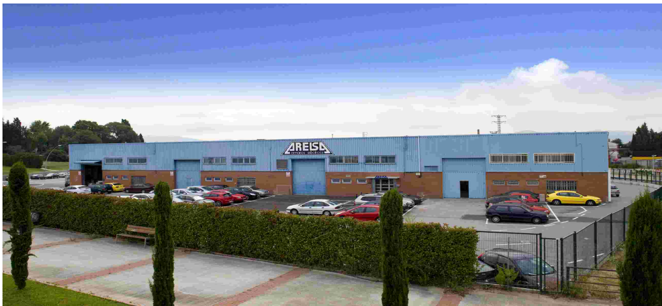
Instalaciones en Lliçà de Vall (Barcelona).
