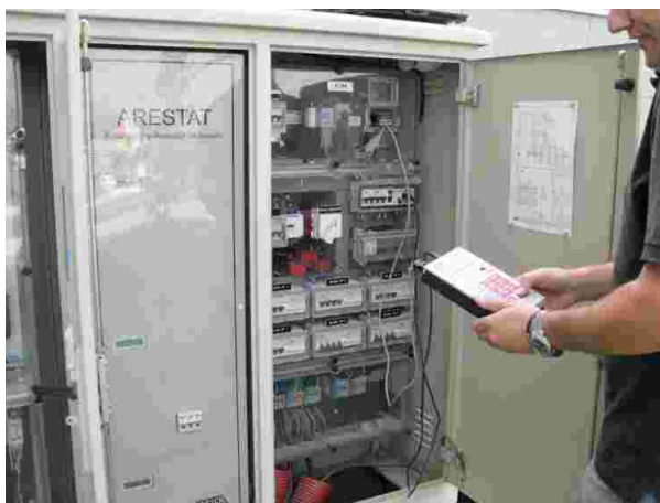
Reparación, ajuste y reprogramación de instalaciones.
